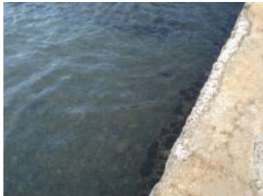
Fotografia 6: Quebra-mar em Santana (norte)
