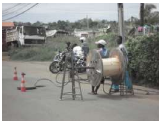
Fotografia 10: Colocação do cabo sob a estrada
