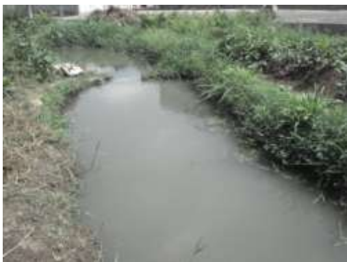
Fotografia 18: Desvio para Irrigação
